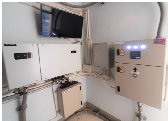
รูปที่ 6 ชุดอินเวอร์เตอร์และระบบเก็บข้อมูลอัจฉริยะ (Smart Logger)
