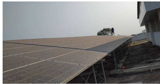
รูปที่ 3 ก่อนล้างทำความสะอาดแผงเซลล์แสงอาทิตย์
