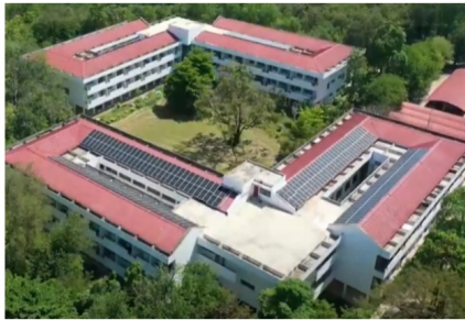
รูปที่ 2 ภาพถ่ายการติดตั้งแผงเซลล์แสงอาทิตย์บนหลังคาขนาด 138.24 kW
